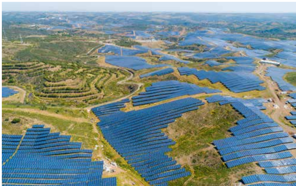
Central Fotovoltaica de Alcoutim | Maio de 2020
